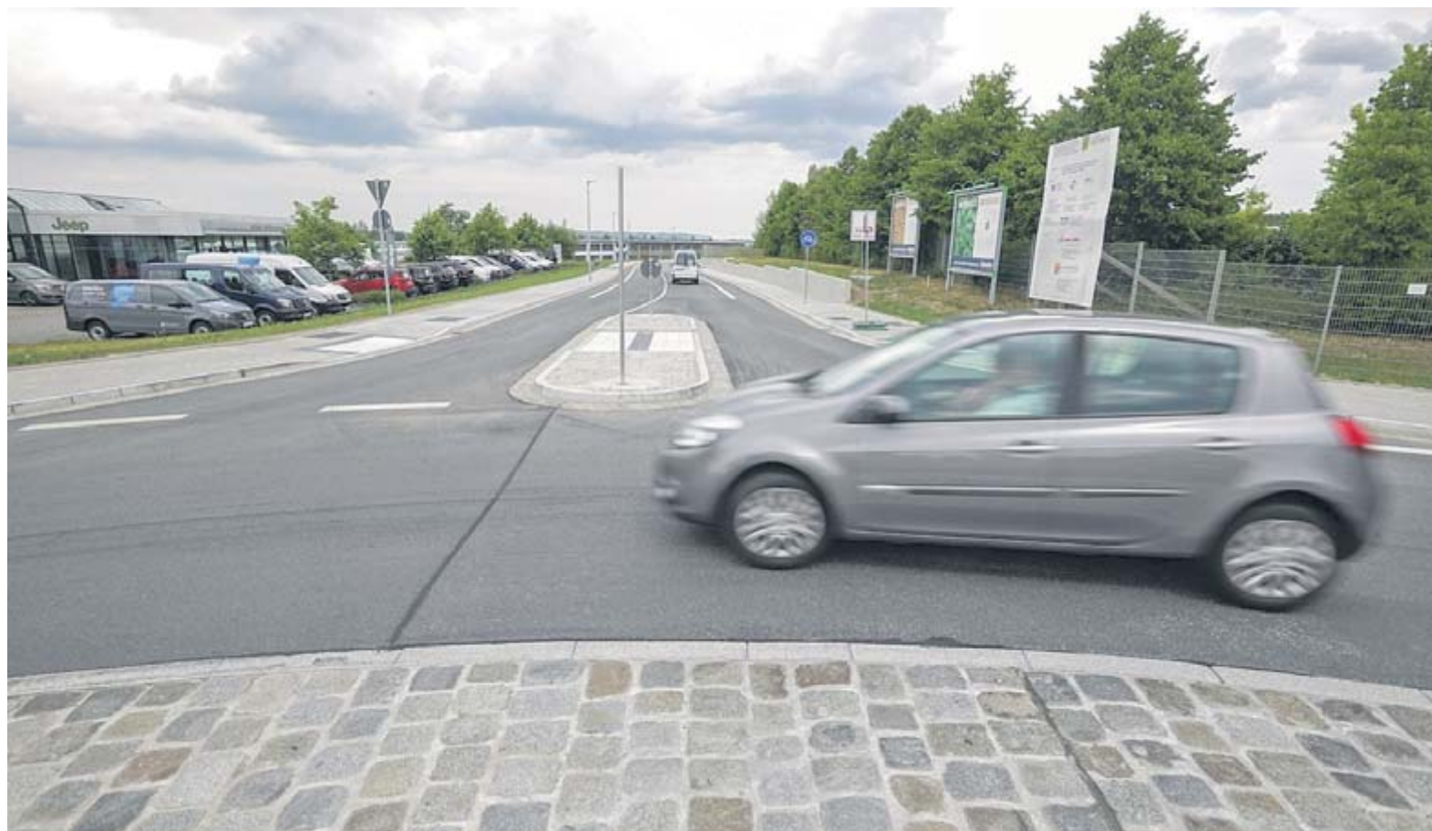
Der Kreisverkehr an der Einmündung der Fraunhoferstraße in die Werner-Seelenbinder-Straße wurde in den vergangenen Monaten neu gebaut. Über den Kreislauf rollen die Fahrzeuge über die F.-O.-Schimmel-Straße zum Südring und weiter auf die Autobahn. FOTO: TONI SÖLL
