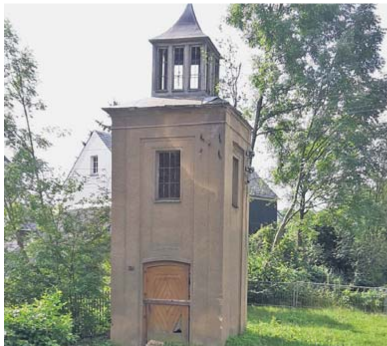
Die alte unter Denkmalschutz stehende Trafostation in Mühlbach soll künftig von Vögeln bewohnt werden. FOTO: UTE GEORGE
