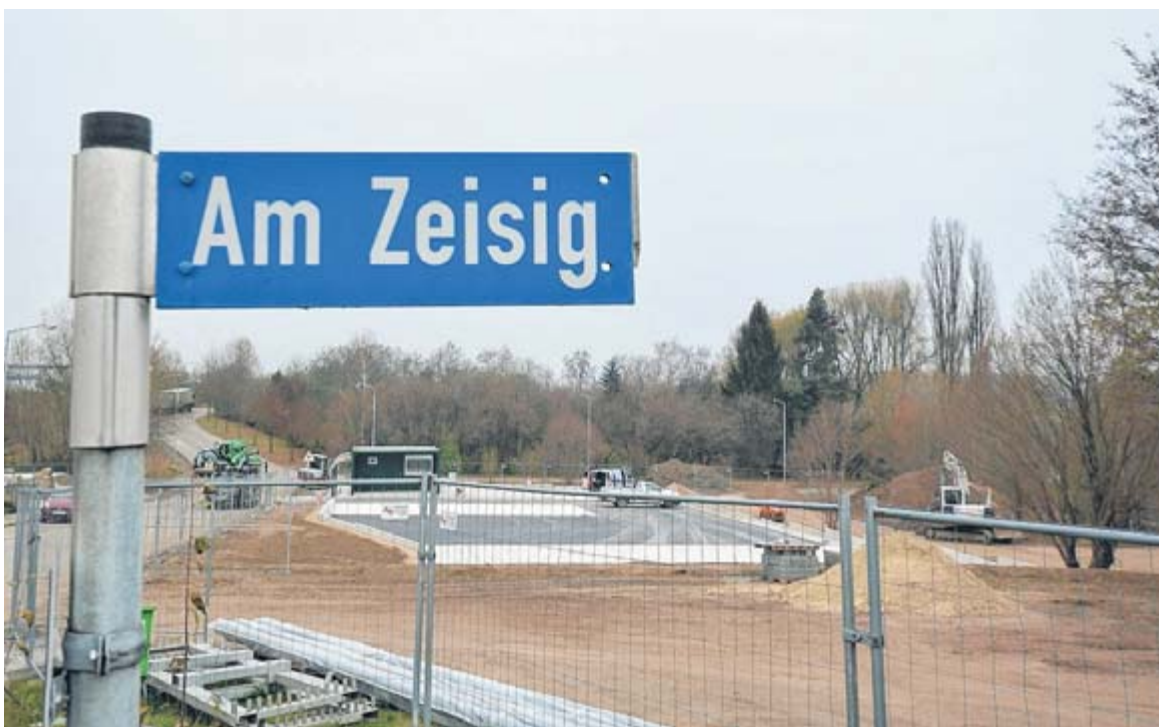
Im Gewerbegebiet Wernsdorf am Zeisig in Penig liegen die Arbeiten für den neuen Wertstoffhof in den letzten Zügen. Die Baufirma Hüttner errichtete die Anlage seit Anfang September. In zwei Wochen ist die Einweihung geplant. Ab Januar soll der Wertstoffhof der Bevölkerung zur Verfügung stehen.
